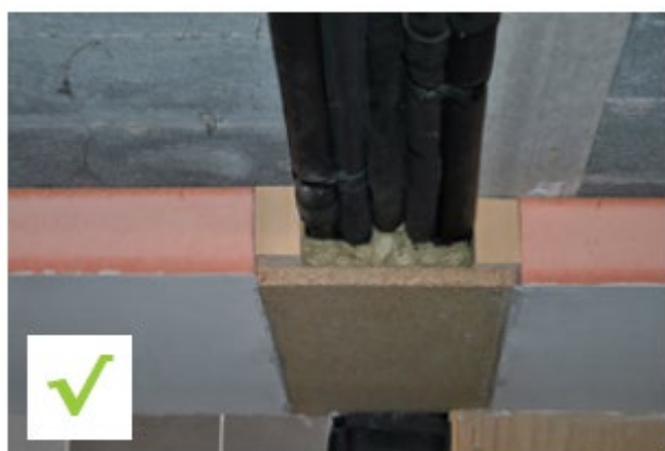
Solution d'isolation de planchers bas sans modification des réseaux existants.
