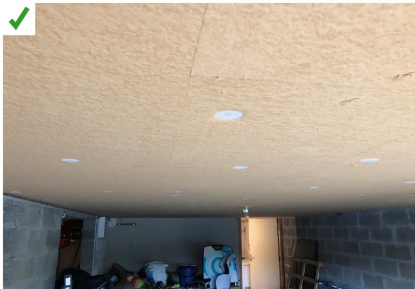
Isolation à l'aide de panneaux semi-rigides rapportés sous dalle. Panneaux posés bord à bord. ©AQC
