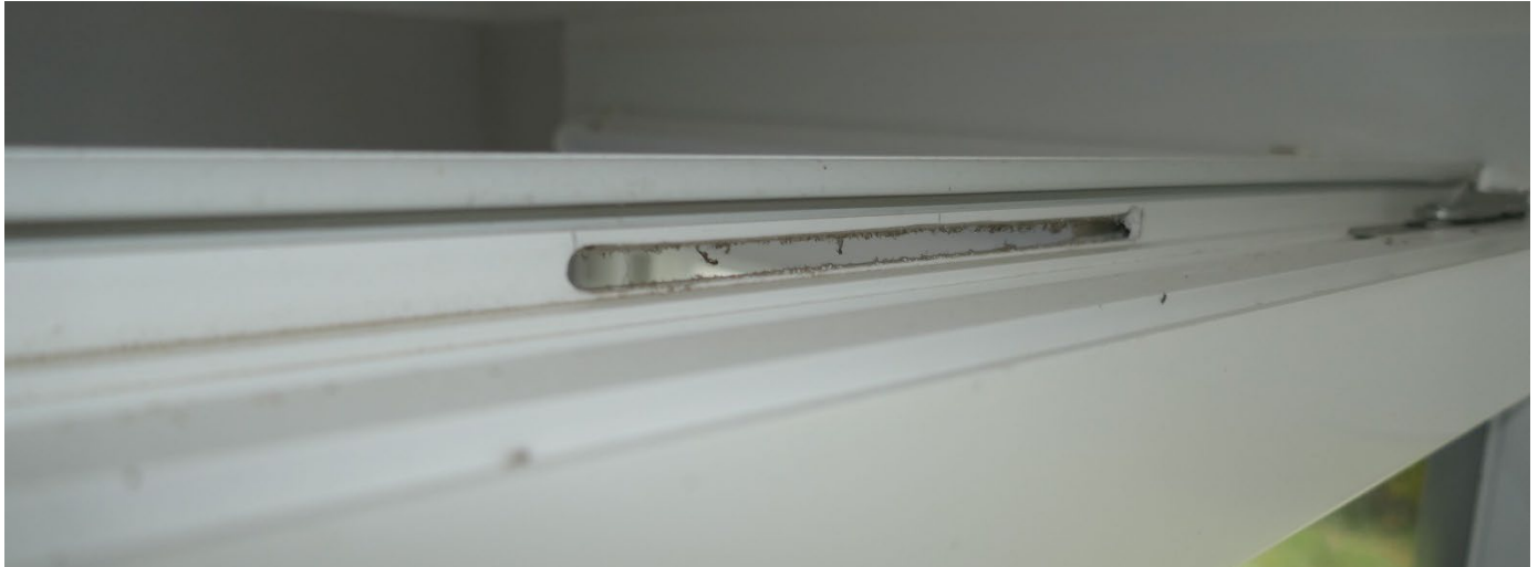
Taille réglementaire des mortaises d'entrées d'air
